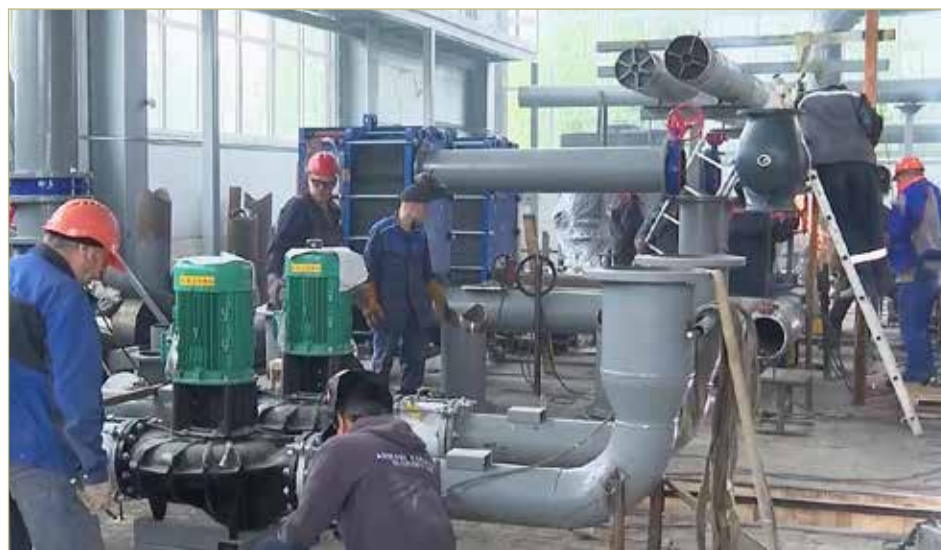
Вместо устаревших котельных, которые работали на угле и дровах, строят новые современные — на газе. А такая модернизация требует серьёзных вложений.
